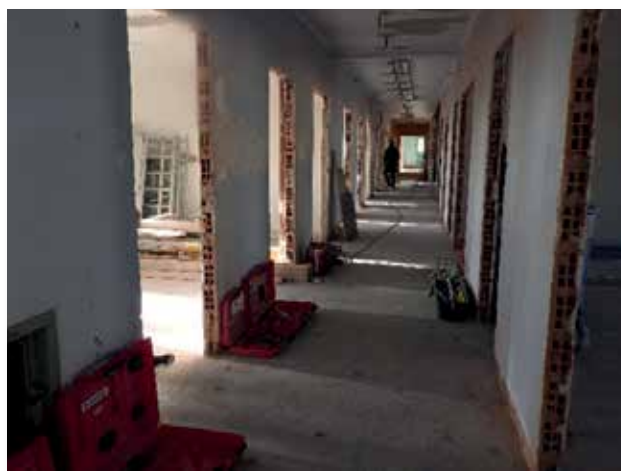
Le long couloir du 2 ème étage périscolaire
