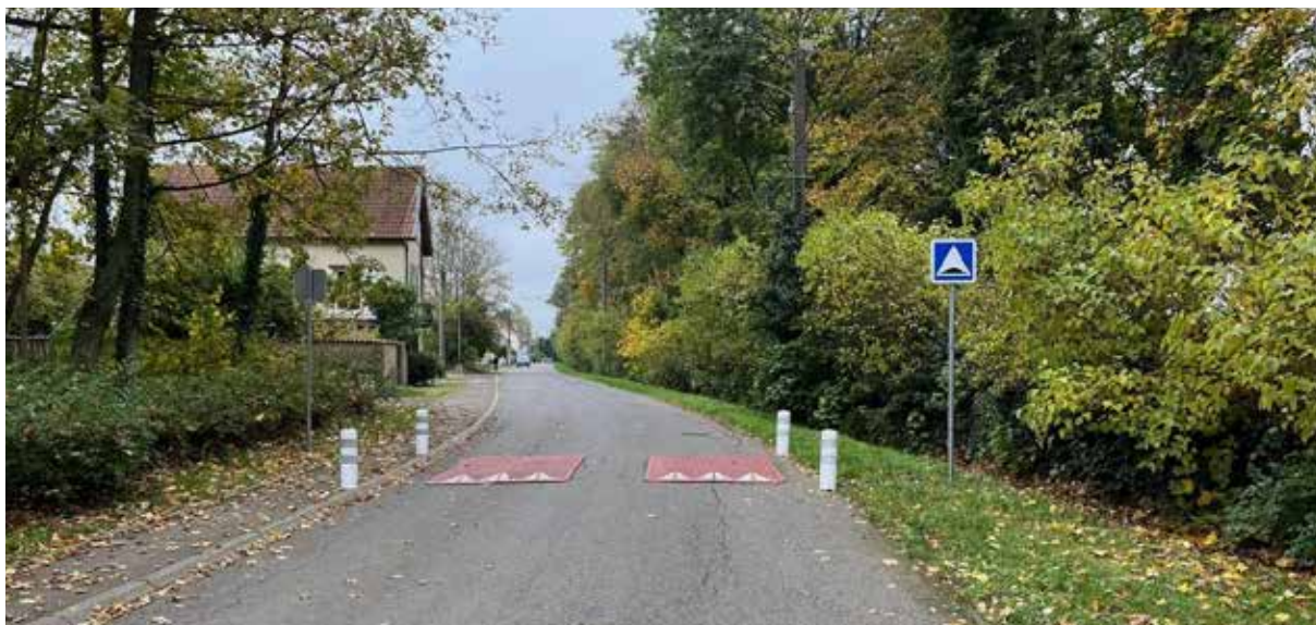
Les deux coussins berlinois installés sont renforcés par des plots visant à rétrécir la perception de largeur de la voirie.
