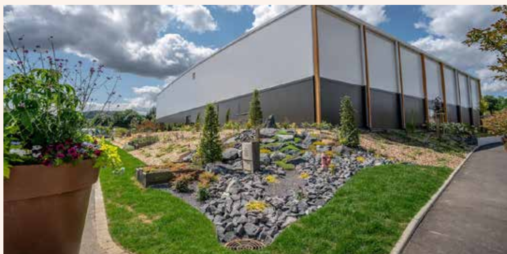
Plateau sportif : des finitions tant esthétiques que qualitatives pour des espaces harmonieux
