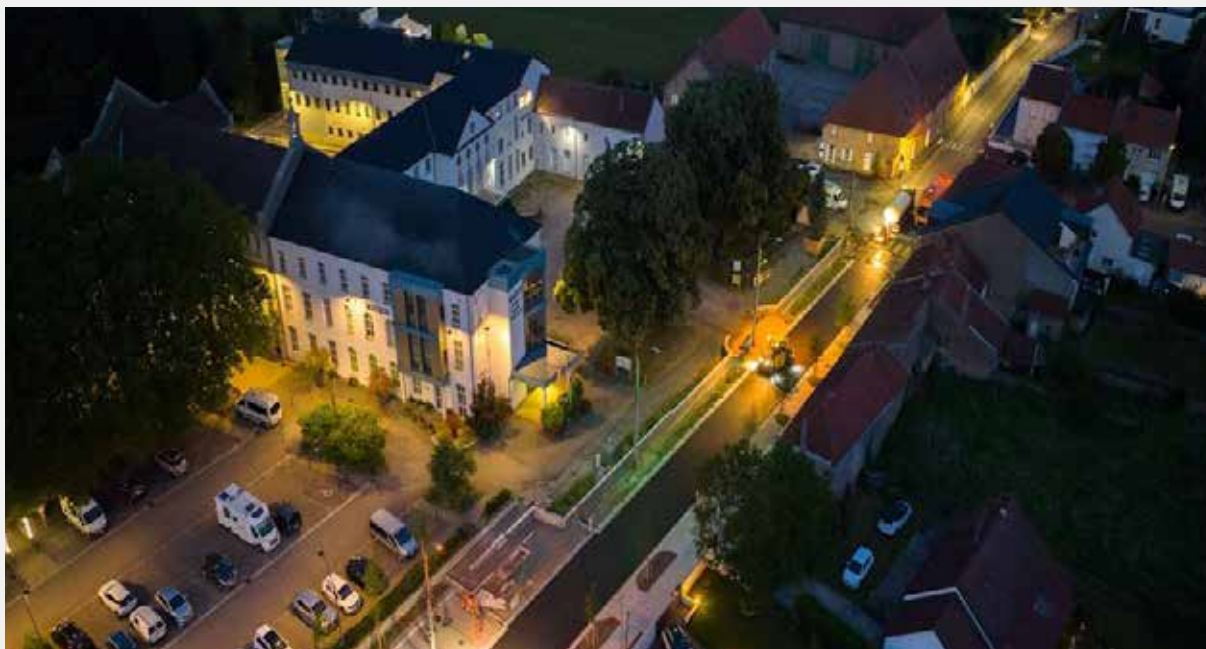
La mise en place de l'enrobé s'est effectué de nuit le 30 août dernier
