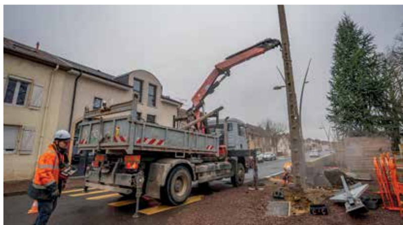
Les anciens poteaux sont démontés.
