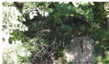
Vue de la fontaine avant sa réhabilitation
