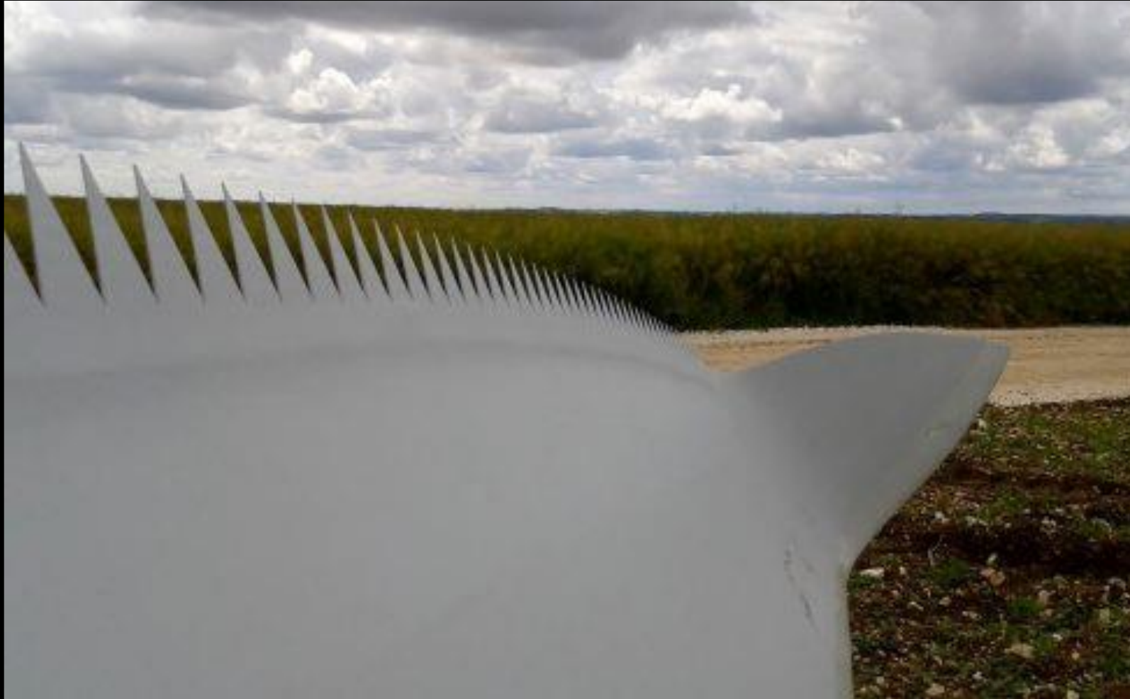
Grâce aux peignes, le bruit généré par les pales des éoliennes n'est quasiment plus perceptible au-delà de 500m de distance
